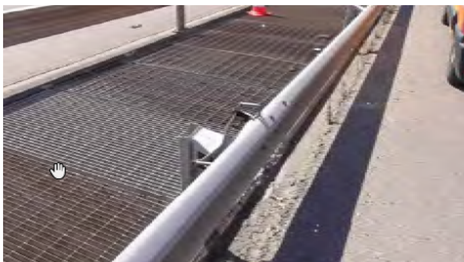
Figure 3: Fixation de dispositif de retenue dégradée
