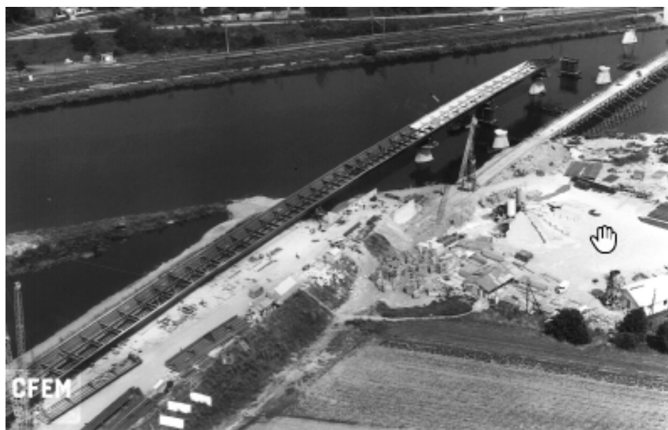
Figure 1: photographie de la construction de l'ouvrage
