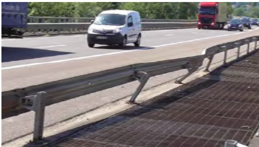
Figure 2: Dispositif de retenue abîmé en TPC suite à un choc
