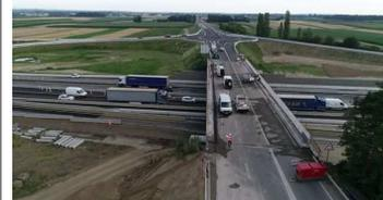
Parmi les défis techniques opérés ces dernières semaines, le vérinage de l'ouvrage de franchissement de l'A35 apparaissait en première position. Pour rappel, il s'agissait de placer provisoirement la structure du tablier du pont sur des vérins afin de disposer de suffisamment de place pour remplacer ses dispositifs d'appui. L'opération a été réalisée avec succès par l'entreprise TSV et ses nouveaux appuis sont désormais opérationnels pour les trente prochaines années.
