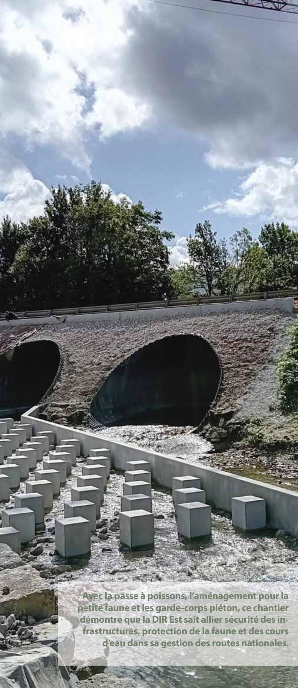
**Avec la passe à poissons, l'aménagement pour la petite faune et les garde-corps piéton, ce chantier démontre que la DIR Est sait allier sécurité des infrastructures, protection de la faune et des cours d'eau dans sa gestion des routes nationales.**
