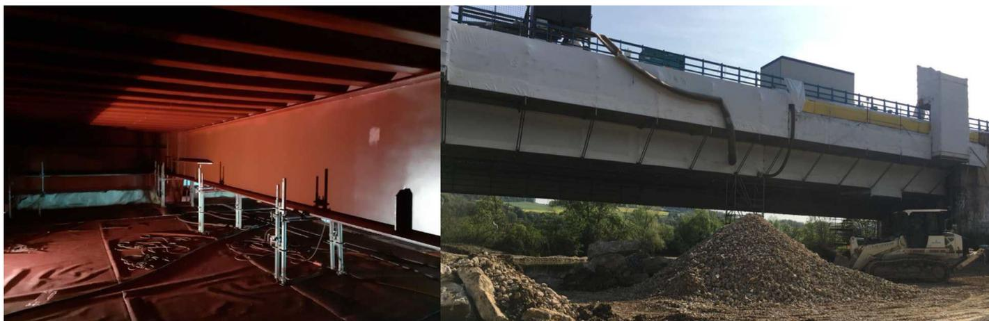
*Application du système anticorrosion et confinement de l'ouvrage pour grenailage de la peinture au plomb - Crédit photo : DIR Est*
