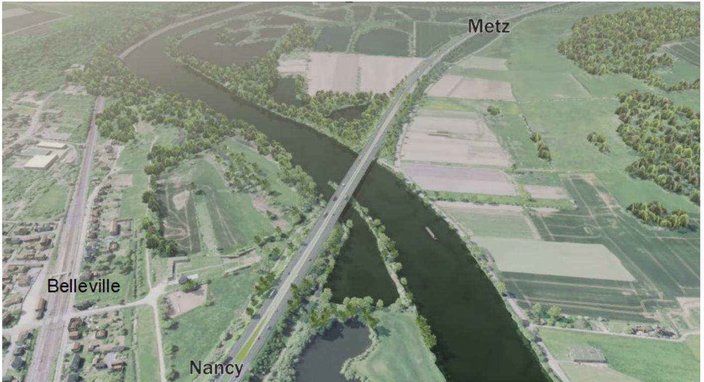
Sa construction date du début des années 1970. Le choix, à cette époque, avait été de construire un ouvrage entièrement métallique, composé d'une dalle orthotrope unique supportant les 2 sens de circulation, avec seulement 2 poutres longitudinales soutenant l'ensemble de la structure (32 mètres de large par 232 mètres de long).
