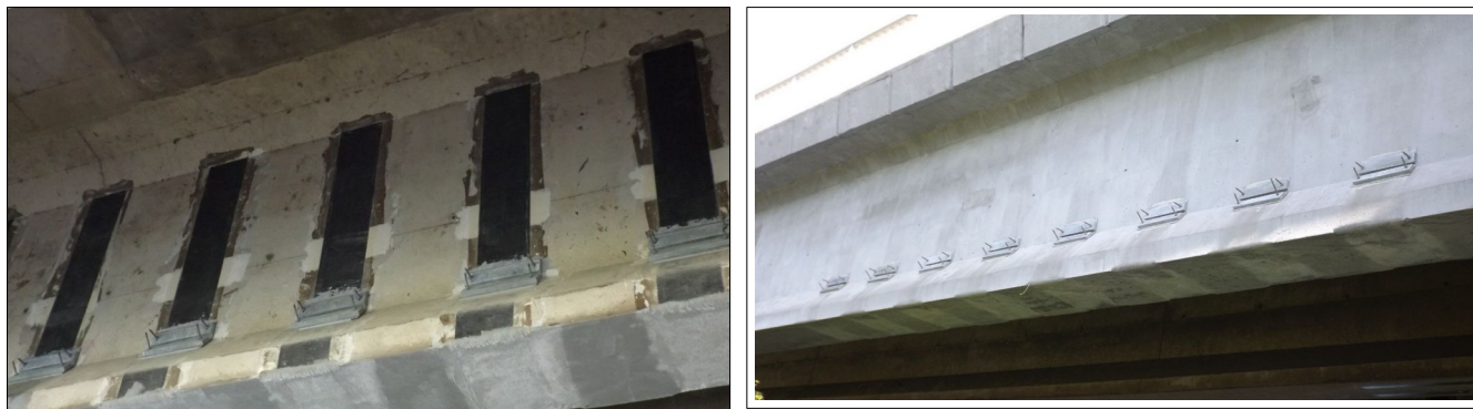
Vues des réparations des talons et renforcements par matériaux composites des poutres en 2019
