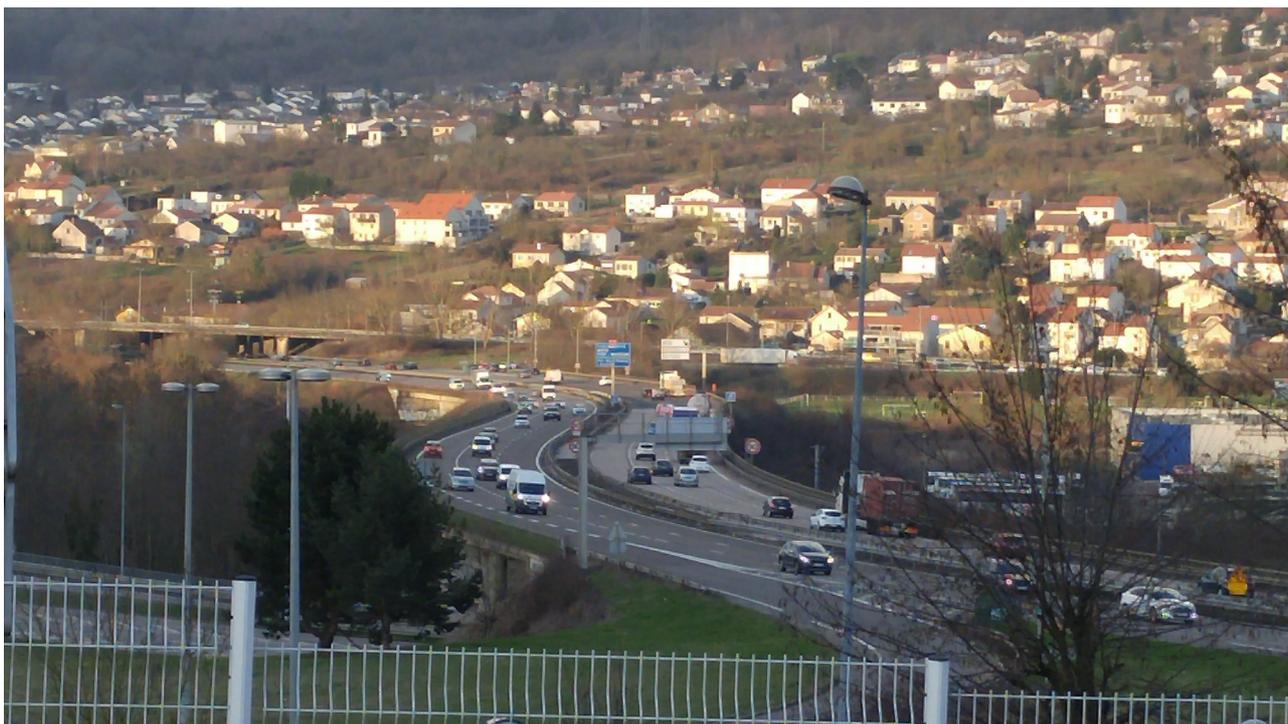
Les travaux programmés, de mi-mai à septembre, porteront sur le pont du sens Nancy vers Metz. Ils comprendront les réparations sur des dalles béton sous la voie lente, le traitement des dispositifs de retenues, le remplacement des joints de dilatation aux extrémités du viaduc et le renouvellement de la couche de roulement.
