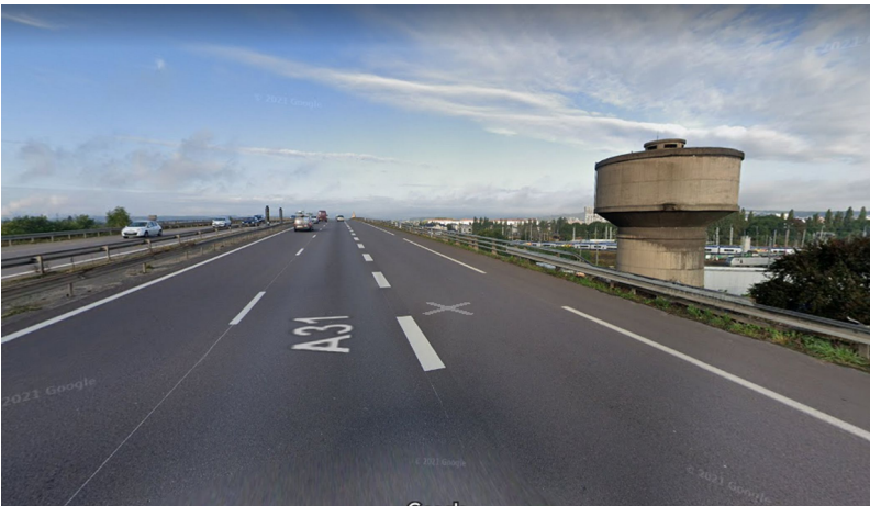
Figure 6: Visibilité du château d'eau depuis l'A31, dans le sens Metz → Luxembourg
