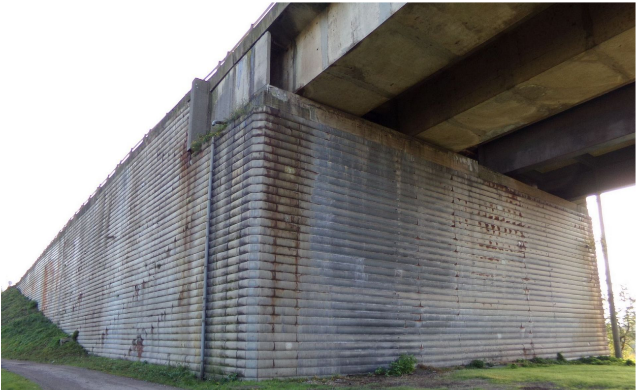
Figure 1: Photo de la culée Terre Armée Est du viaduc de Beauregard
