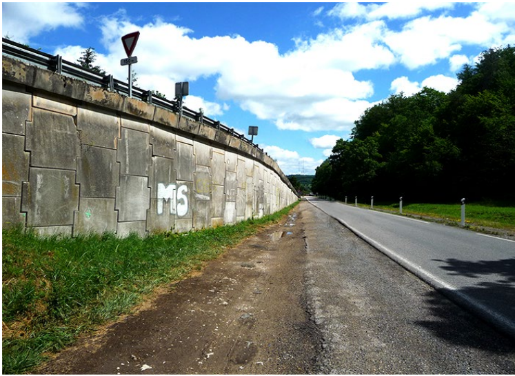
Mur en terre armée
