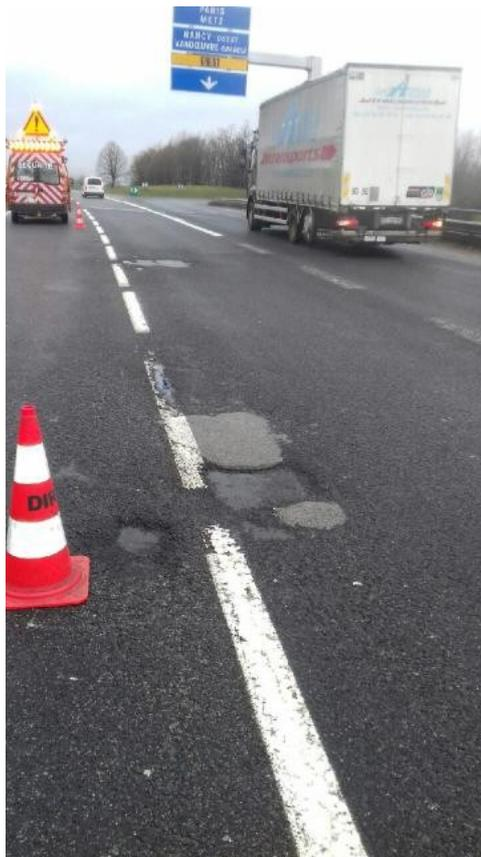
En raison du trafic (40 000 véhicules/jour dont 10% de PL), du climat et du phénomène de gél/dégel la chaussée se détériore avec le temps et connaît de nombreuses dégradations qui concernent les différents niveaux de la chaussée :
