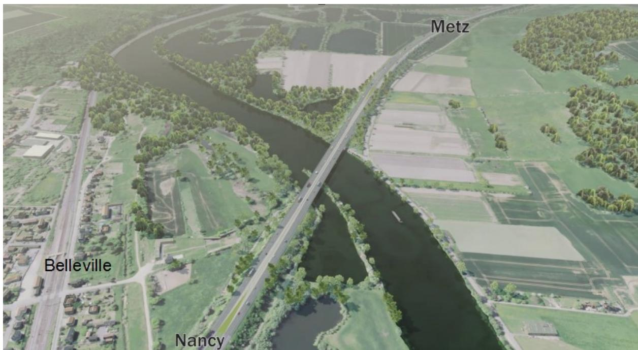
Sa construction date du début des années 1970. Le choix, à cette époque, avait été de construire un ouvrage entièrement métallique, composé d'une dalle orthotrope unique supportant les 2 sens de circulation, avec seulement 2 poutres longitudinales supportant l'ensemble de la structure (32 mètres de large par 232 mètres de long).
