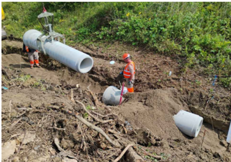
Pose de canalisation
