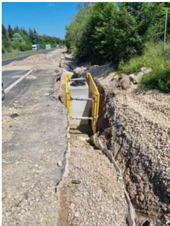
Blindage de fouille
