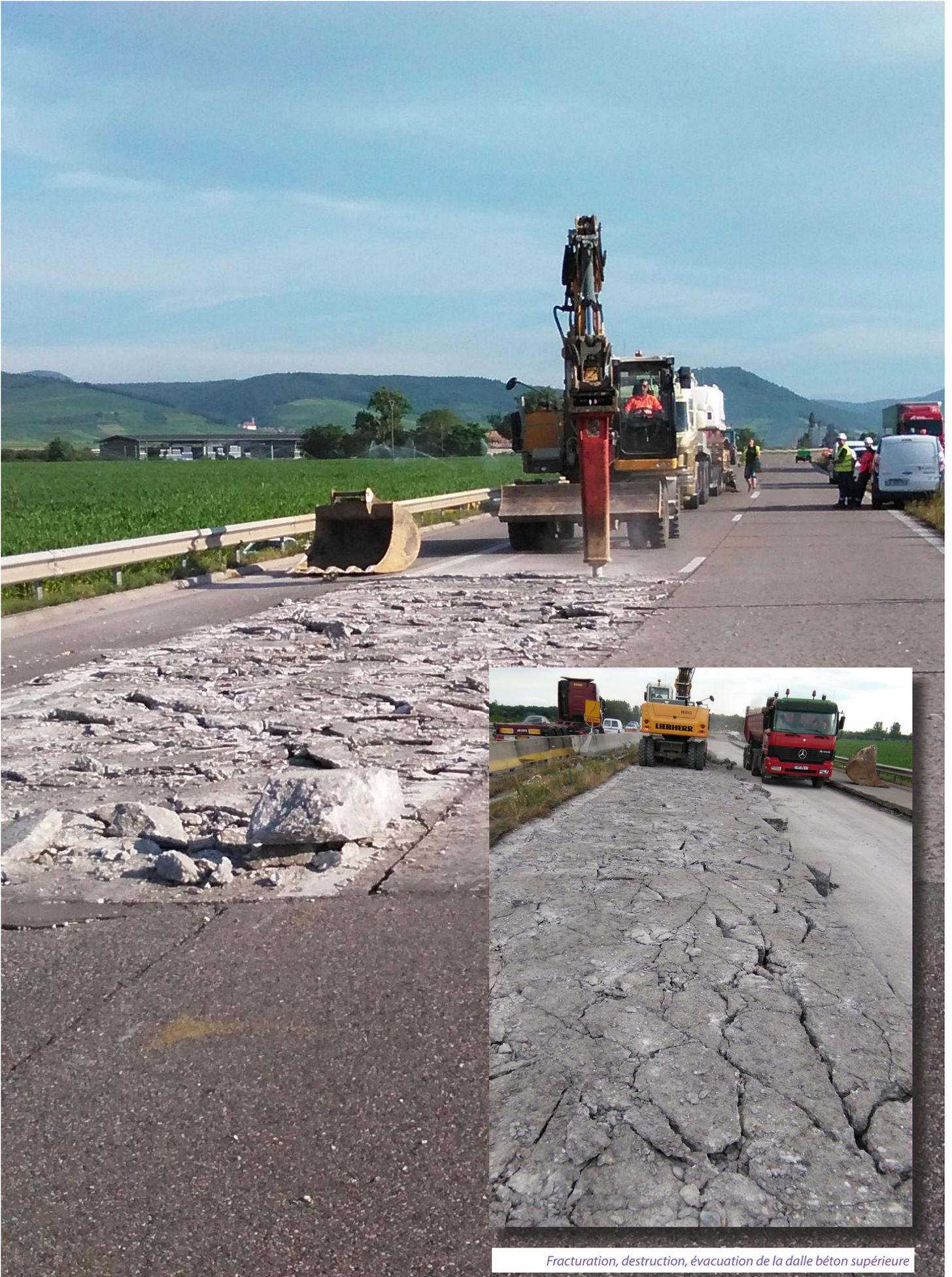
Fracturation, destruction, évacuation de la dalle béton supérieure
