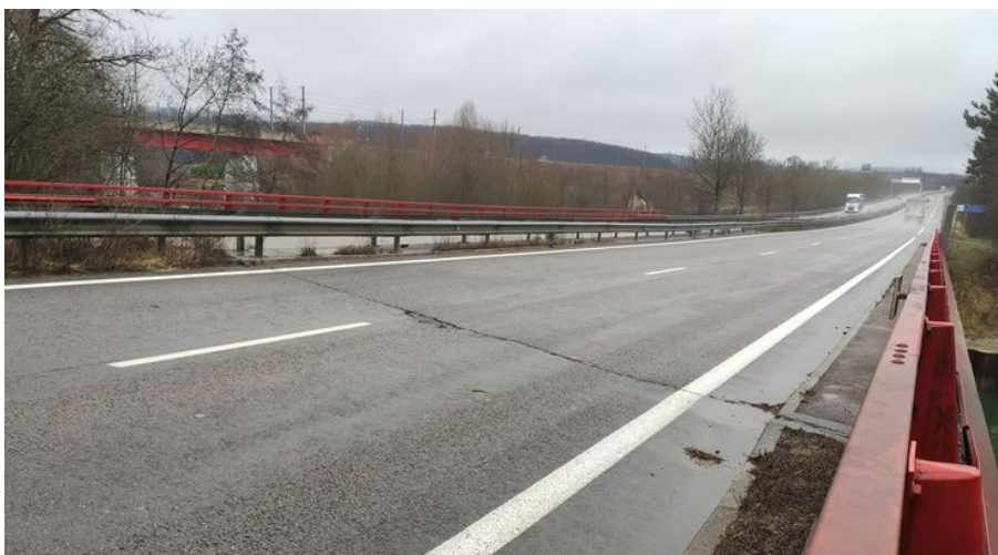
Pont de la RN57 à Voray-s-l'Ognon – vue du dessus
