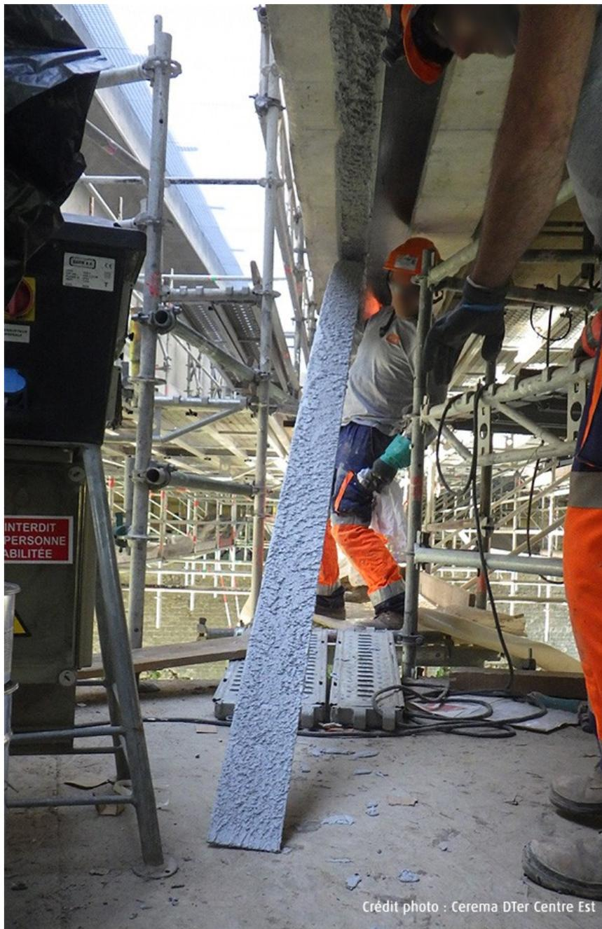
*Exemple de collage d'une lamelle en carbone sous ouvrage*
