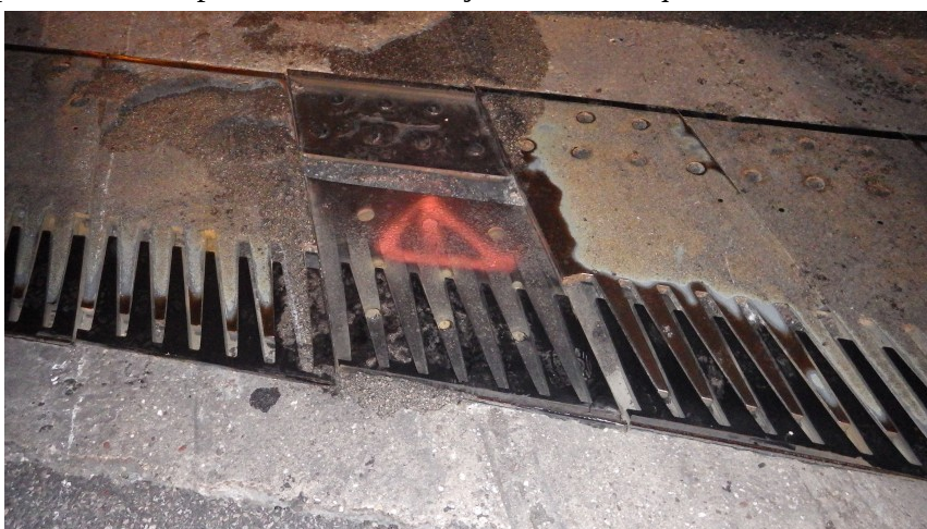
Photo du joint existant
