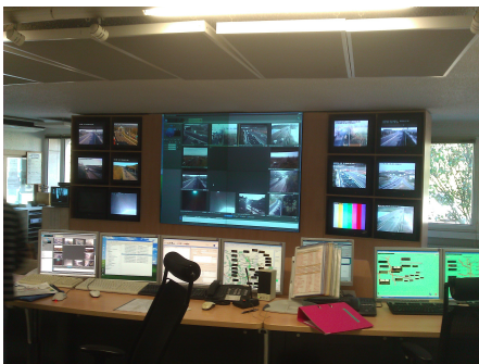
Salle de contrôle du CISGT
