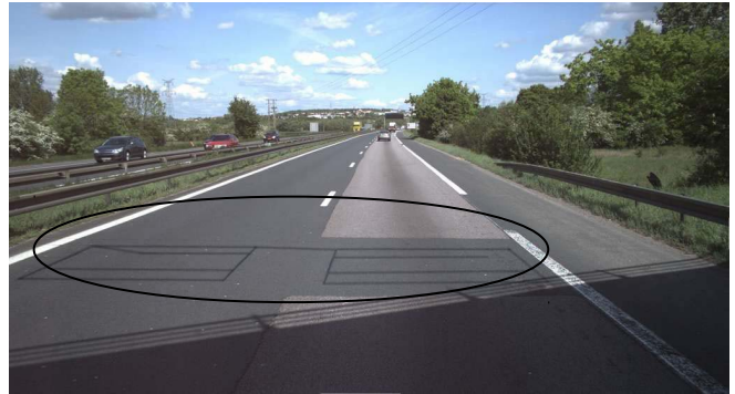
Boucle magnétique (comptage routier)
