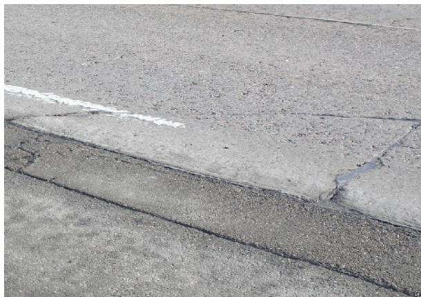
3 - à la **dégradation de l'interface** entre la **dalle béton** et la **Bande d'Arrêt d'Urgence** (d'où les neutralisations de BAU mises en place en 2011)
